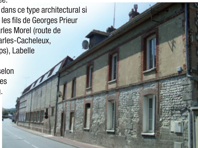
Les plus anciens locaux industriels de Labelle sont bâtis en moellons calcaires du pays et avec quelques pierres de taille en chaînage. Rien ne distingue cette manufacture d'une habitation familiale.
